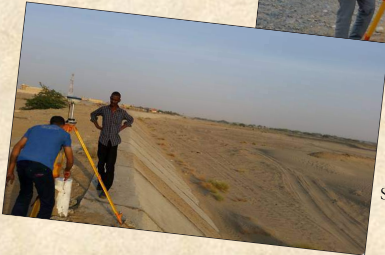
مرحلة تثبيت النقاط الأساسية Phase of fixation of the main points
