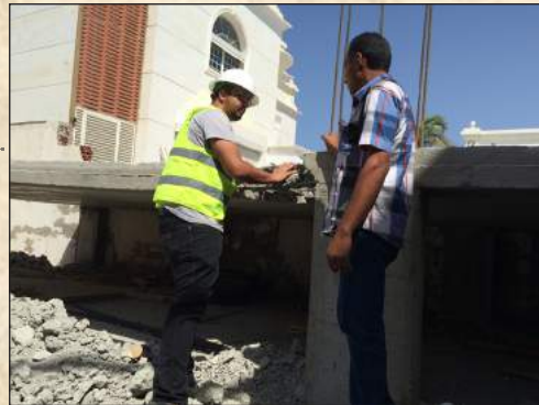
متابعة أعمال الترميم والإزالةات Follow-up re-construction and removal works
