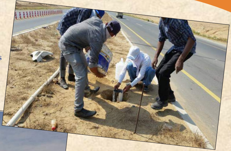
مرحلة توقيع أماكن البتر Phase of signing the places for the Concrete
